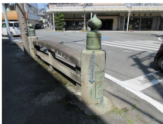
筋向橋の欄干
