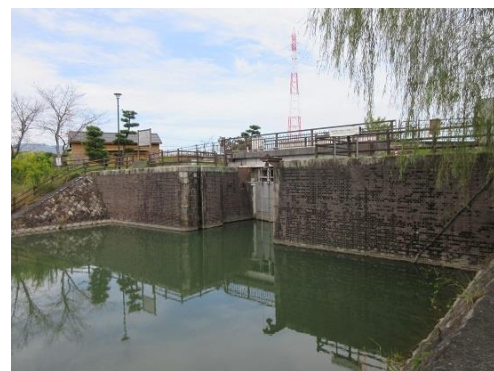
閘門長良川側
