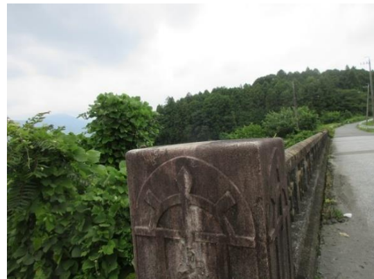
昔ながらのコンクリート橋・山田橋
